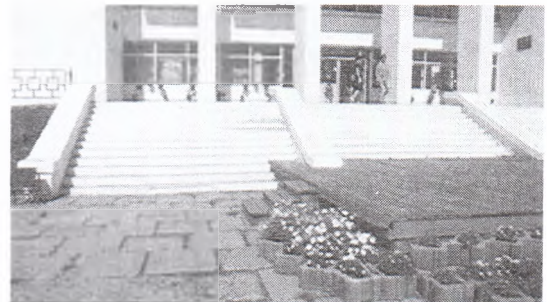
Фото №6 – Центральная лестница для входа в здание ДК
