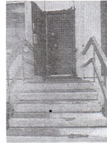
Фото №18- Запасной выход №2
