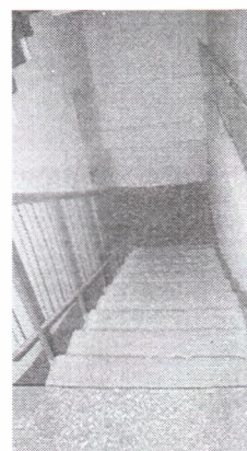
Фото №14- Пути движения внутри здания ДК (лестничный марш)
