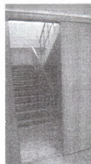
Фото №12- Пути движения внутри здания ДК (вход на второй этаж)
