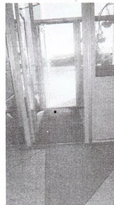
Фото №10- Вход в здание ДК (тамбур)
