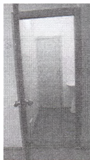
Фото №23- Санитарно-гигиенические помещения
