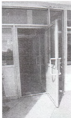
Фото №9- Вход в здание ДК (входная площадка)
