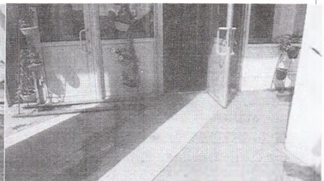
Фото №8- Вход в здание ДК (входная площадка)
