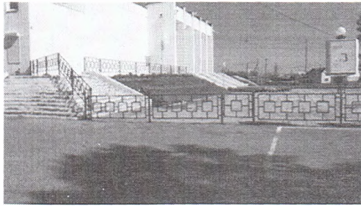
Фото №1 - Прилегающая территория (автостоянка)
