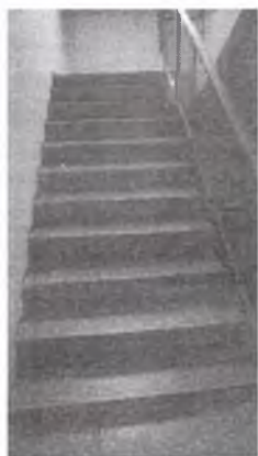
Фото №13- Пути движения внутри здания ДК (лестничный марш)
